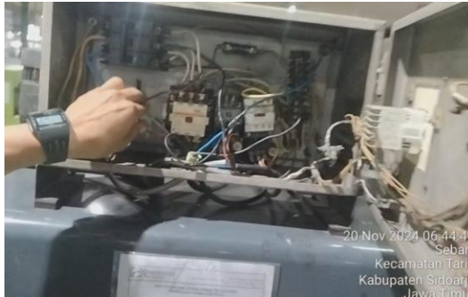
Gambar Pengecekan Kabel
