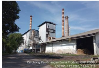
Cerobong Pembuangan Emisi Produk GKP PGDBU -7.53795, 112.2286, 58,8m, 218°
