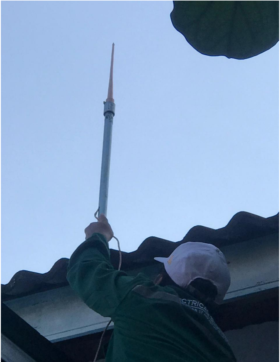
Foto pemasangan penangkal petir
