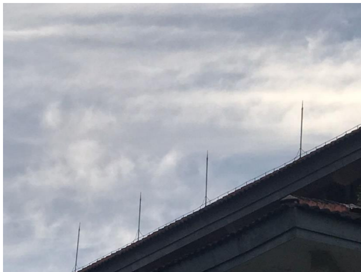
Foto setelah melakukan pemasangan penangkal petir
