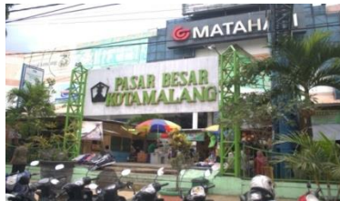
Gambar 2.8 Kondisi Pasar Yang Terlihat Kumuh
