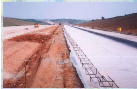
Gambar 2.4 Struktur lapis bond breaker
