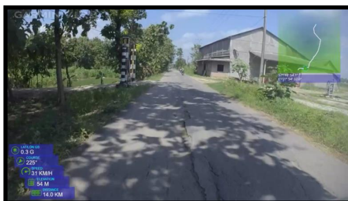
Kondisi Ruas STA 13+200
