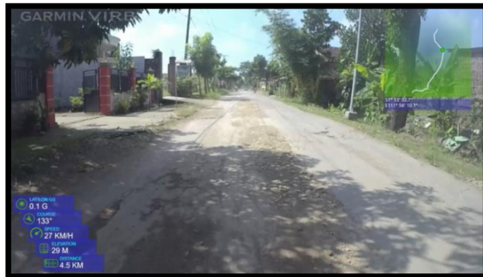
Kondisi Ruas STA 4+500
