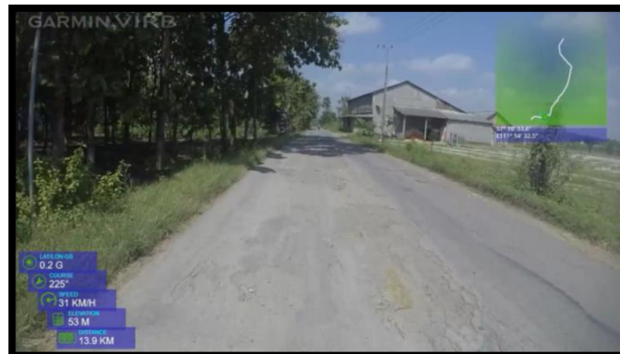
Kondisi Ruas STA 13+100
