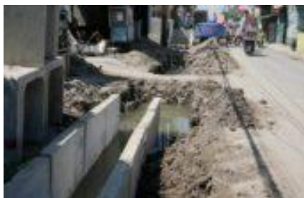
Dokumentasi pelaksanaan kegiatan pembuatan saluran u-ditch dan betonisasi jalan di Desa Kwangsang
