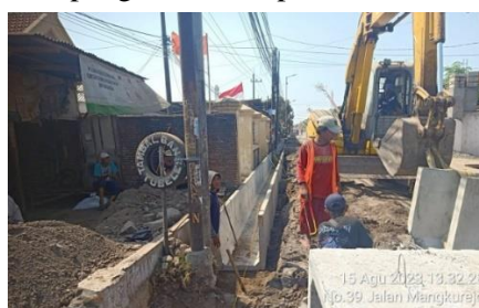
Dokumentasi pelaksanaan kegiatan pembuatan saluran u-ditch dan betonisasi jalan di Desa Kwangsang
