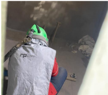
proses manual sandblasting dilakukan.
