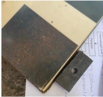
Gambar 3.16 Persiapan Permukaan Baja Sebelum Blasting
