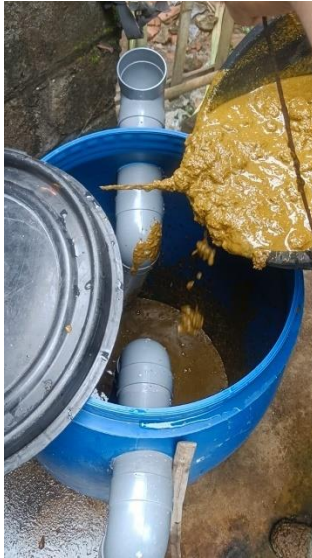
Lampiran 1. 1 Memasukan Kotoran Sapi Kedalam Digester
