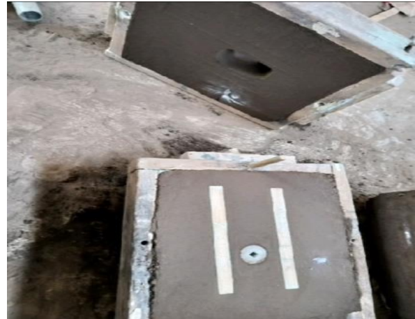
Gambar 8. Pembongkaran Cetakan
