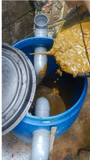
Lampiran 1. 1 Memasukan Kotoran Sapi Kedalam Digester
