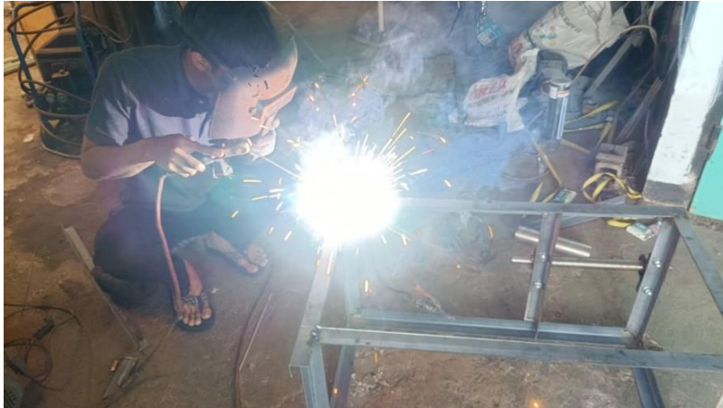
Perakitan dan pengelasan Rangka mesin
