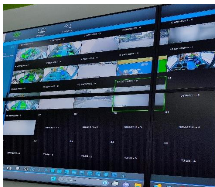
Dokumentasi 30: LCD Proyektor Pusat Kontrol Operasional Bus Trans Jatim
