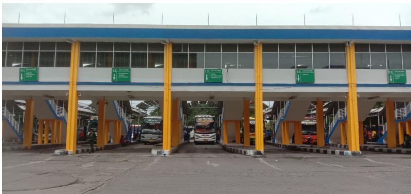
Penampakan shelter keberangkatan bus terminal Purabaya
