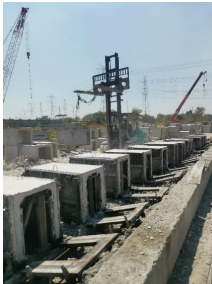
Gambar Uditch yang sudah di Cor
