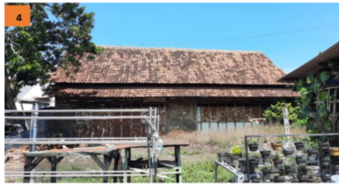
Gambar 8 Kondisi Lokasi Bekas Bongkar Muat Barang Stasiun Ponorogo
