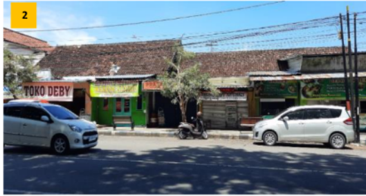
Gambar 6 Kondisi Bangunan Kantor Stasiun Ponorogo
