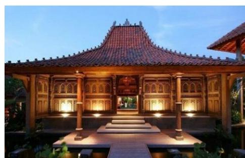
Gambar 4. Atap limasan dari rumah adat jawa tengah (rumah limasan)
