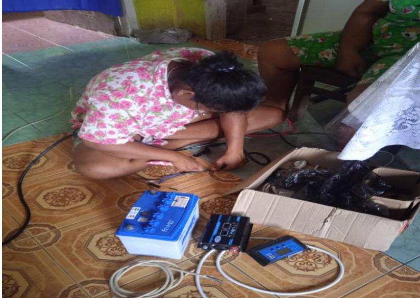
Penyambungan kabel dari baterai dan inverter juga Panel surya ke SCC dari rumah warga daya 384 Watt
