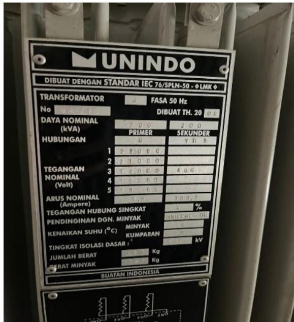
Transformator 200 KVA
