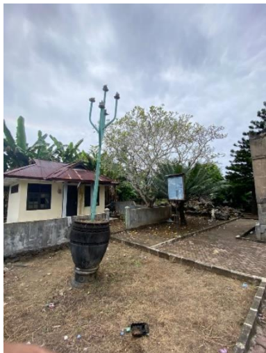
Sisi Barat Pintu Masuk
