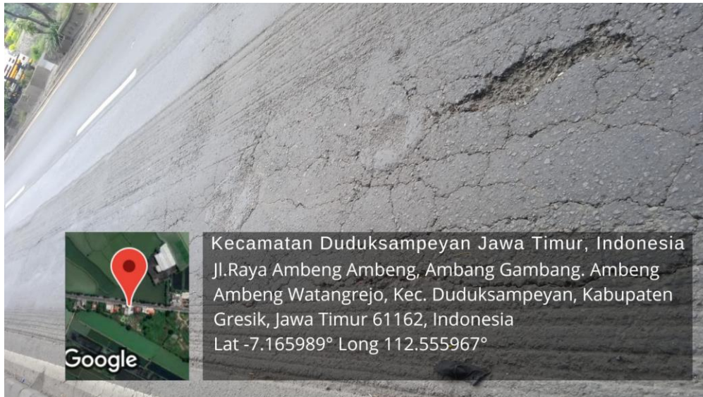
Gambar Lampiran 1. g Kondisi jalan mengalami retak dan berigi (Sumber : Dokumentasi Pribadi)
