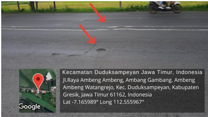
Gambar Lampiran 1. b Terlihat kerusakan jalan arah balik dan pergi yang bergelombang dan berlubang STA 26+300 (Sumber : Dokumentasi Pribadi)
