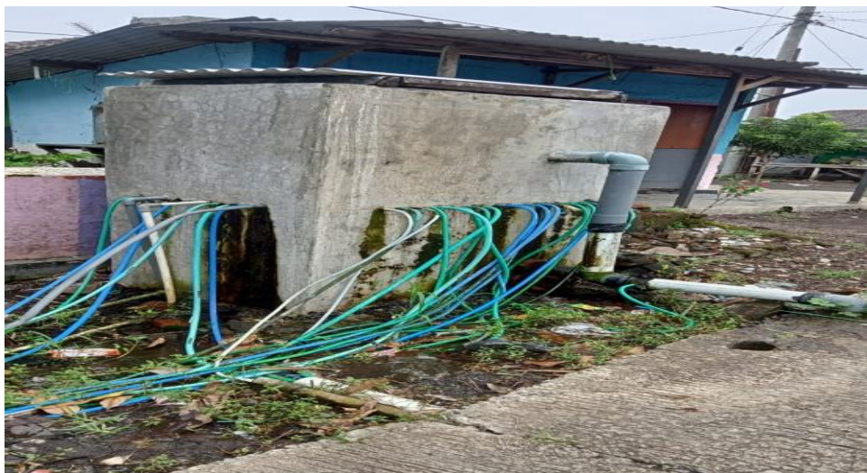
Gambar 5 Foto Survey Lokasi Hidran Umum Eksisting
