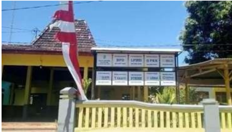
Kantor Balai Desa Remen
