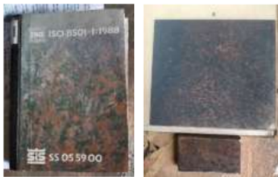
Gambar 3. 4 Persiapan Permukaan Baja Sebelum Blasting
