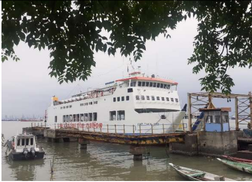
Dermaga Pelabuhan Kamal-Madura
