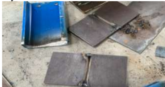
Gambar 3. Tack weld pada material
