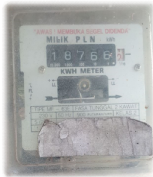
Gambar IV.2 Kondisi kWh Meter Setelah 24 Jam
