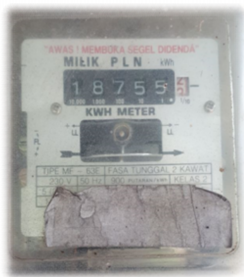
Gambar IV.1 Kondisi Awal kwh Meter Saat Uji Coba
