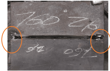
Gambar 5 Pembuatan Track Weld
