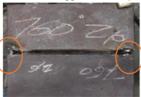
Gambar 5 Pembuatan Track Weld
