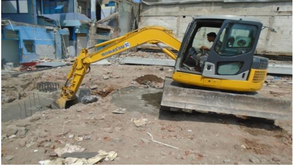
Gambar 1. Pekerjaan Galian Menggunakan Excavator
