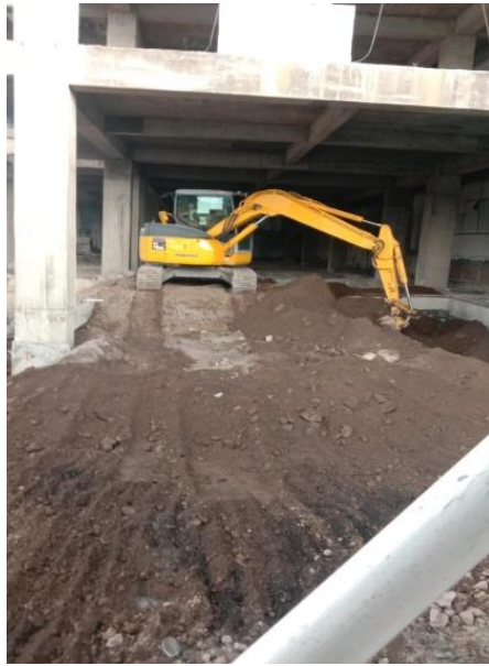
Gambar 3. Pekerjaan Urugan Menggunakan Excavator
