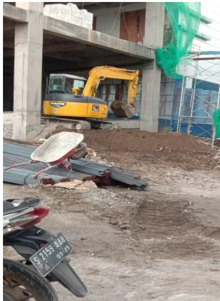
Gambar 4. Pekerjaan Urugan Menggunakan Excavator
