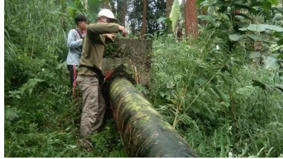
Dudukan belokan pipa pesat
