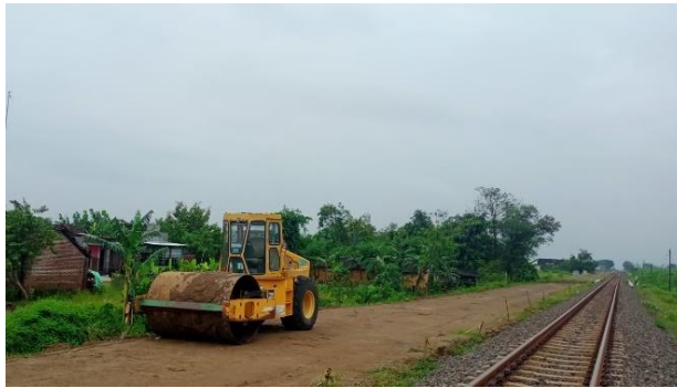
Gambar Perbaikan Tanah Dengan Replecement Soil KM 51+000 – KM 52+500
