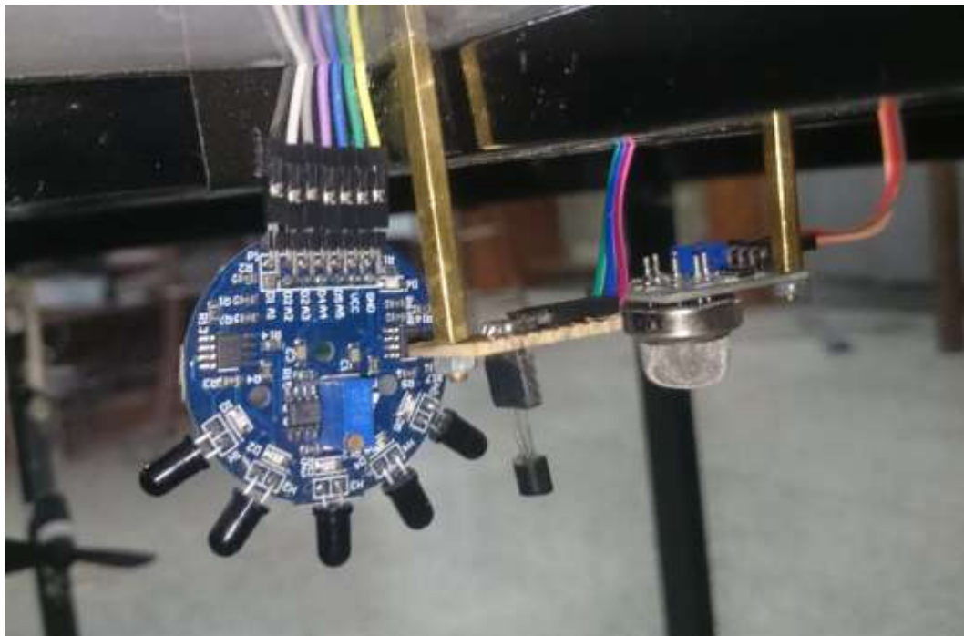
Foto pemasangan flame sensor, MQ-02 dan LM35DZ pada atap ruangan simulasi
