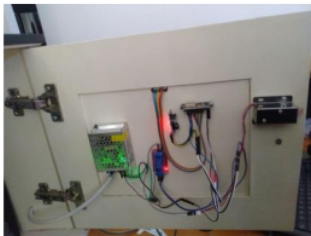
Gambar 7 Alat yang sudah dipasangkan di Objek
