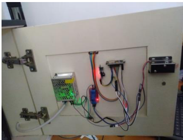
Gambar 7 Alat yang sudah dipasangkan di Objek
