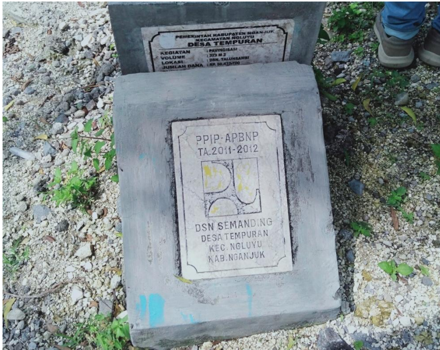
Gambar 9 Foto Survey Lokasi Ground Resevoir Eksisting
