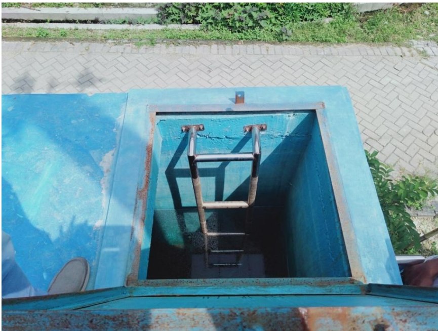
Gambar 8 Foto Survey Lokasi Ground Resevoar Eksisting
