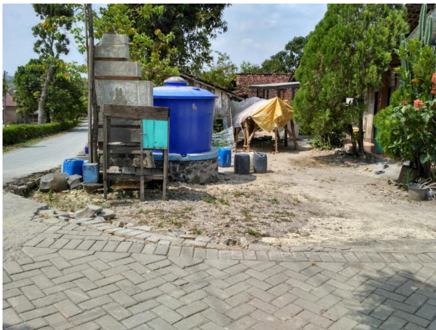
Gambar 5 Foto Survey Lokasi Hidran Umum Eksisting
