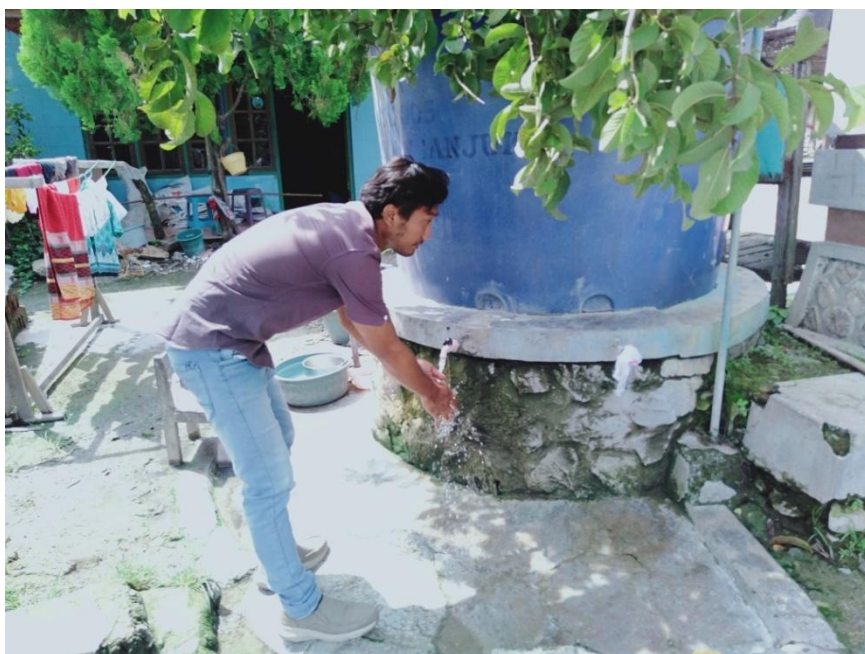
Gambar 6 Foto Survey Lokasi Hidran Umum Eksisting
