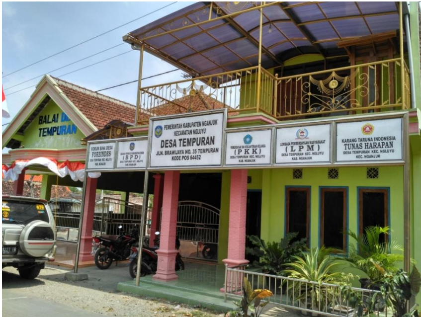
Gambar 1 Foto Survey Lokasi Balai Desa Tempuran
