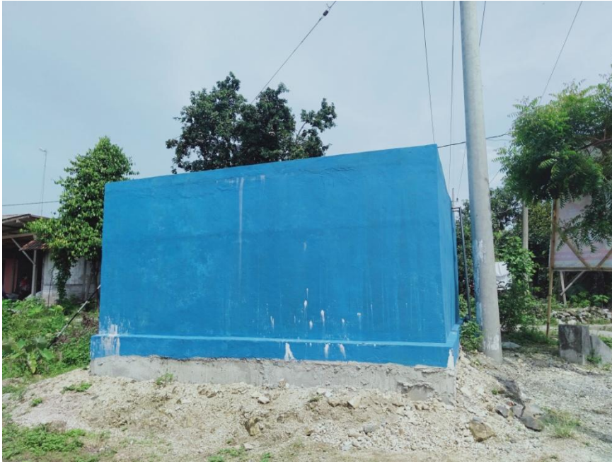
Gambar 7 Foto Survey Lokasi Ground Resevoar Eksisting
