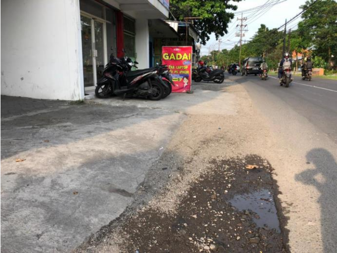
Bahu jalan yang ada di arah A
