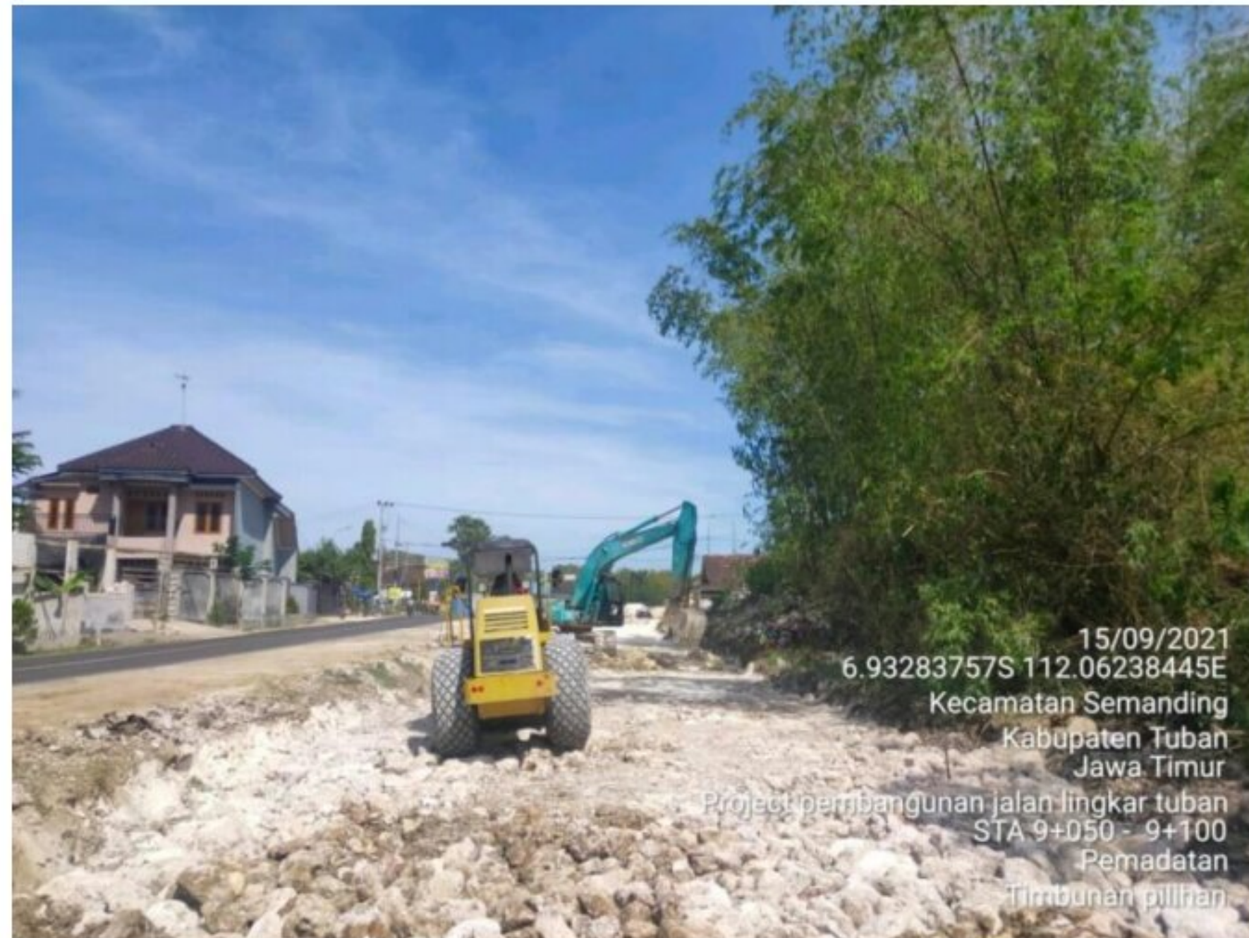
Gambar 3.1 Timbunan pilihan untuk perbaikan tanah lendutan
