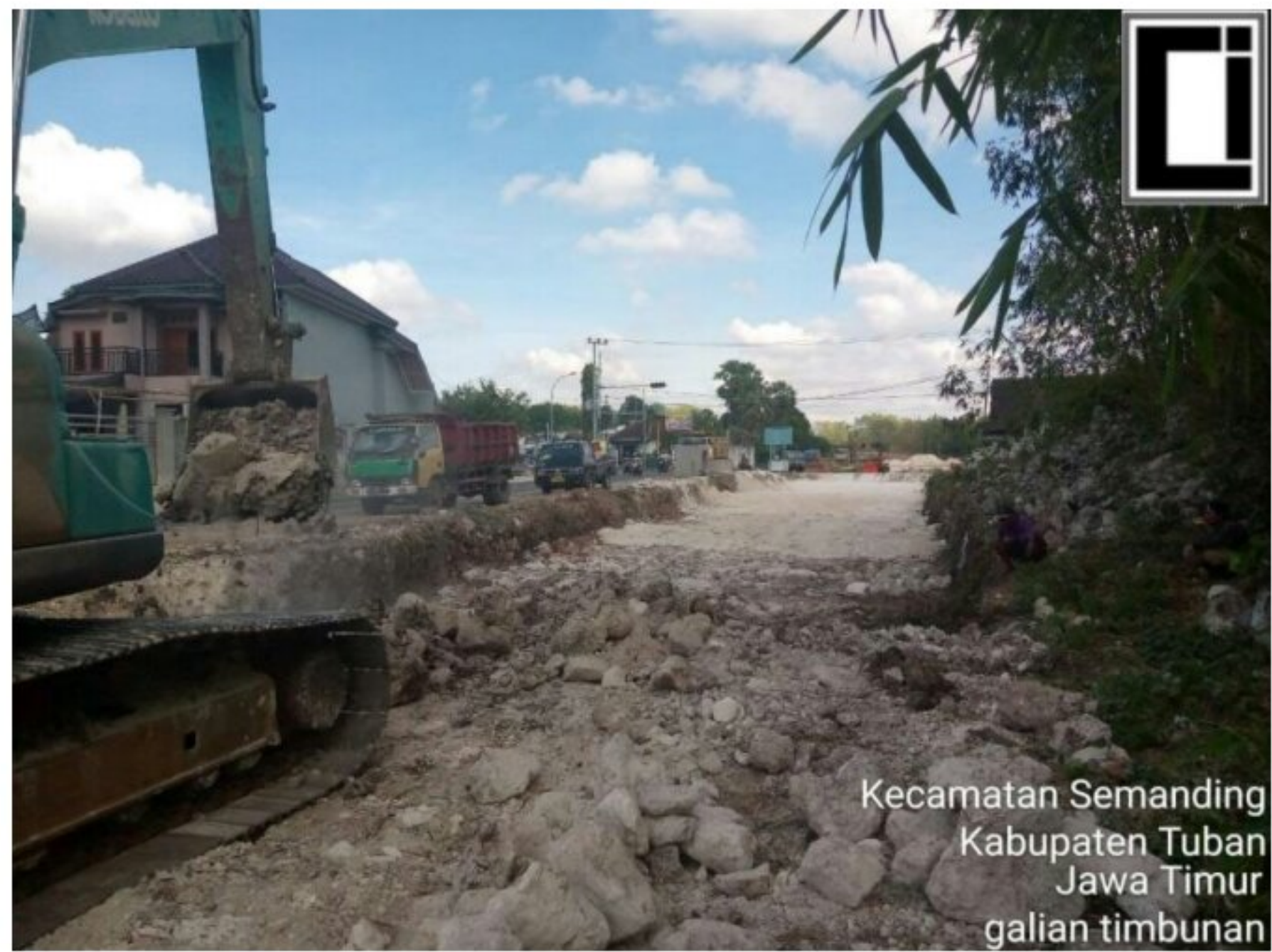
Gambar 1.2 Perbaikan timbunan pilihan hasil galian
