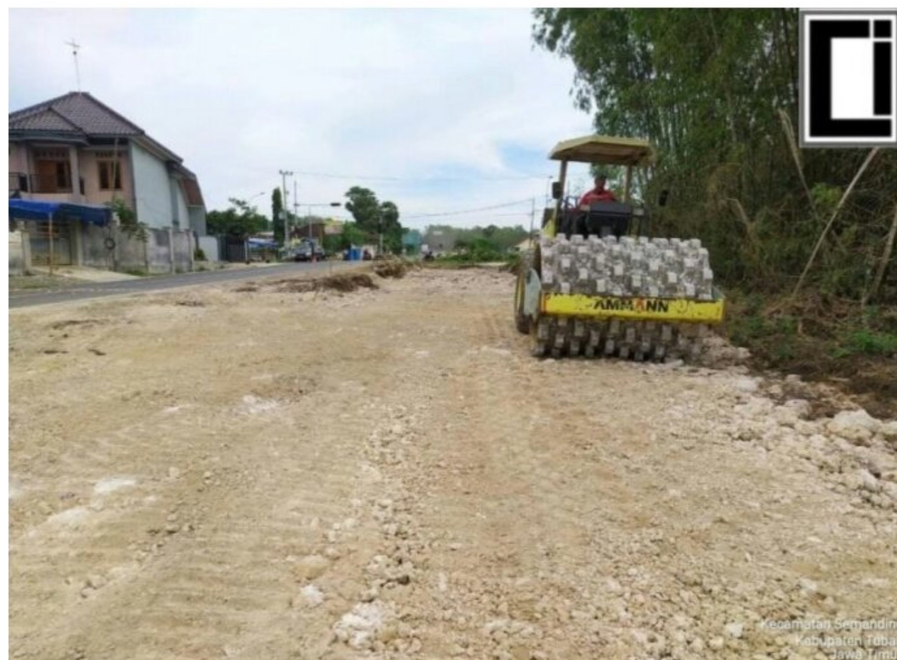
Gambar 3.2 Pemasangan timbunan pilihan akibat tanah lendutan
