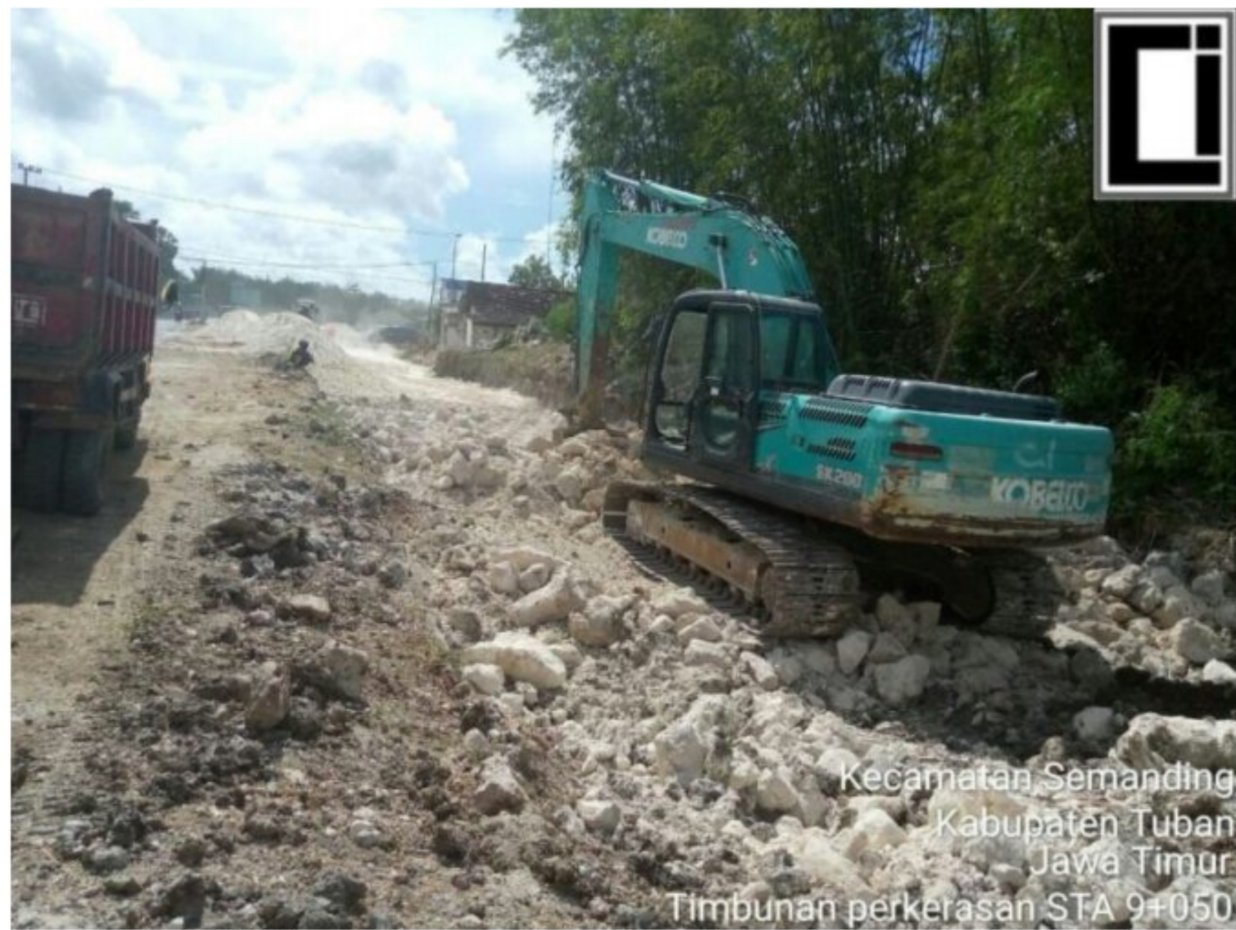
Gambar 2.1 Timbunan perkerasan STA 9+050 s/d STA 9+075
