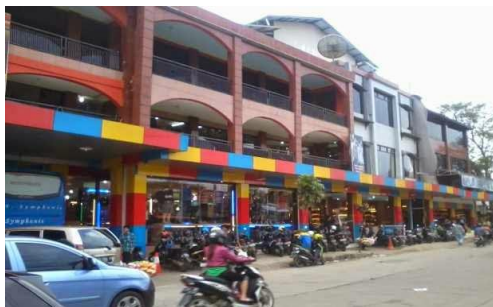
Gambar 2.11: Bangunan di Cibaduyut
