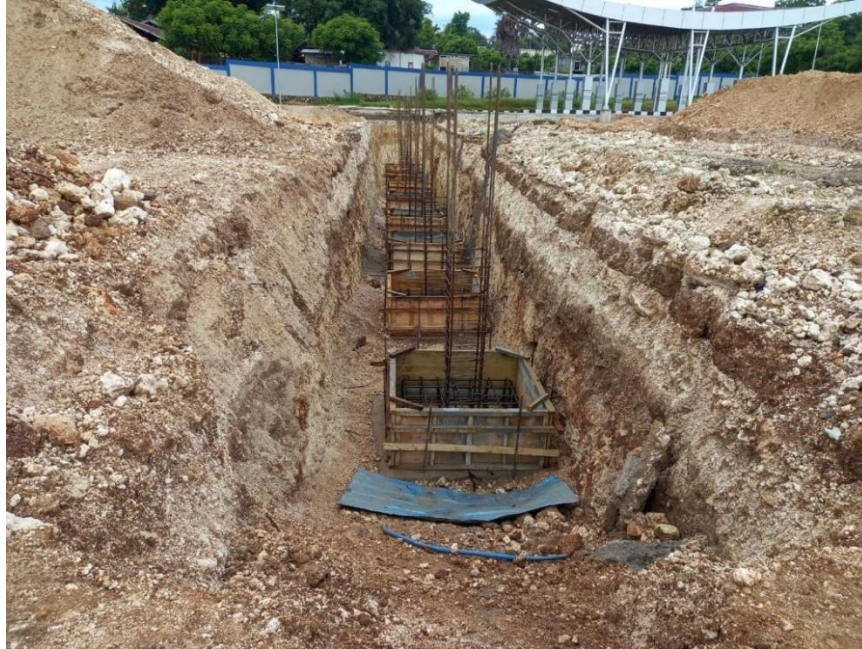
Gambar Pekerjaan Pondasi
