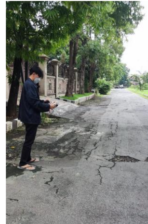
Gambar 5. Pengambilan gambar lubang jalan
