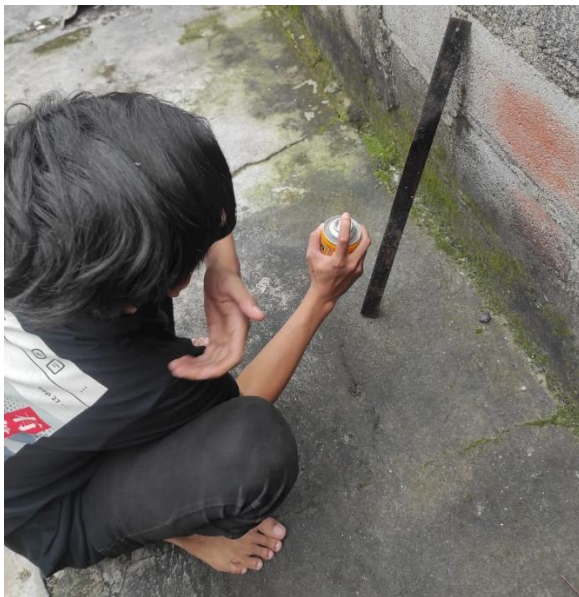
Gambar pengecatan rangka penyangga
