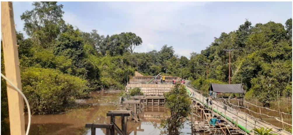
Gambar 1.3 Kondisi Lapangan Jembatan Sungai Ihi (Sumber: Dokumentasi pribadi)
