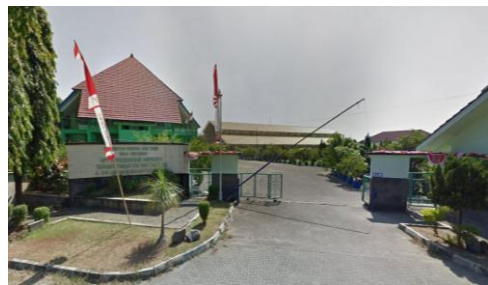
Tampak depan bangunan
