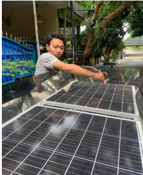
Pemasangan reflektor
