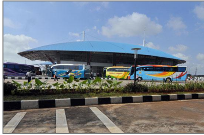
Gambar 2.43 Eksterior Terminal Pulo Gebang
