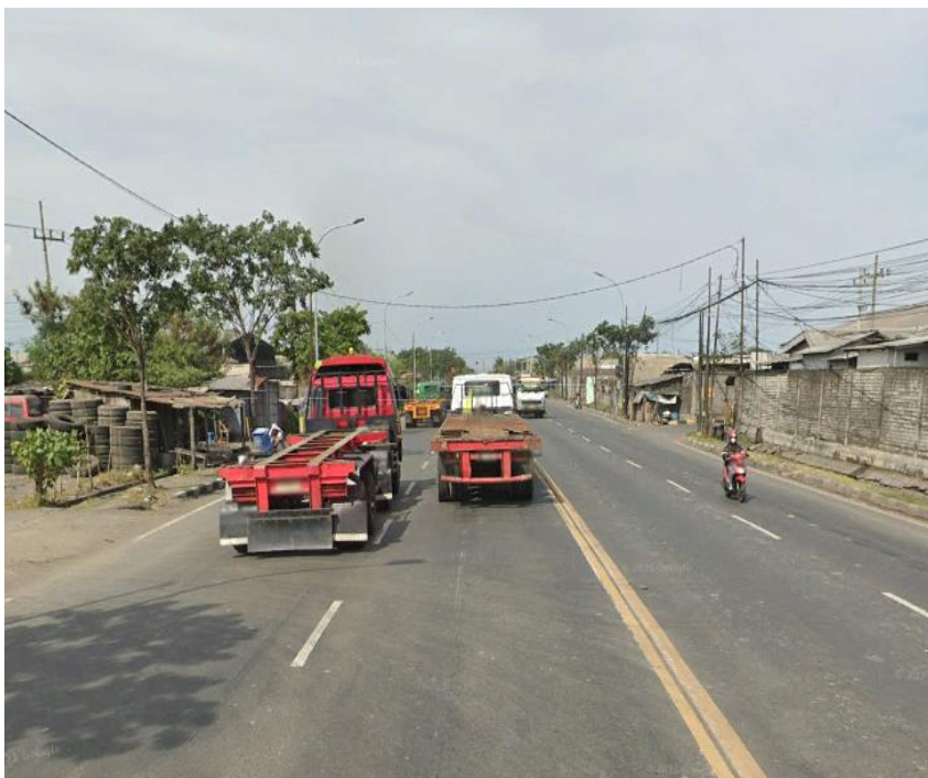
Gambar C.7 Keadaan Ruas Jalan Greges Timur-Kalianak Barat Arah B
