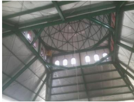
Gambar 4.8.8b. Rangka Atap Baja Sumber: Google
