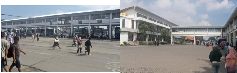
Jalur Keberangkatan Bus dan Jembatan penyeberangan Terminal Purabaya
