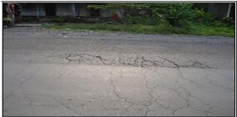
Gambar 2.2 retak Halus Sumber: Sri Sunaryo, 2011
